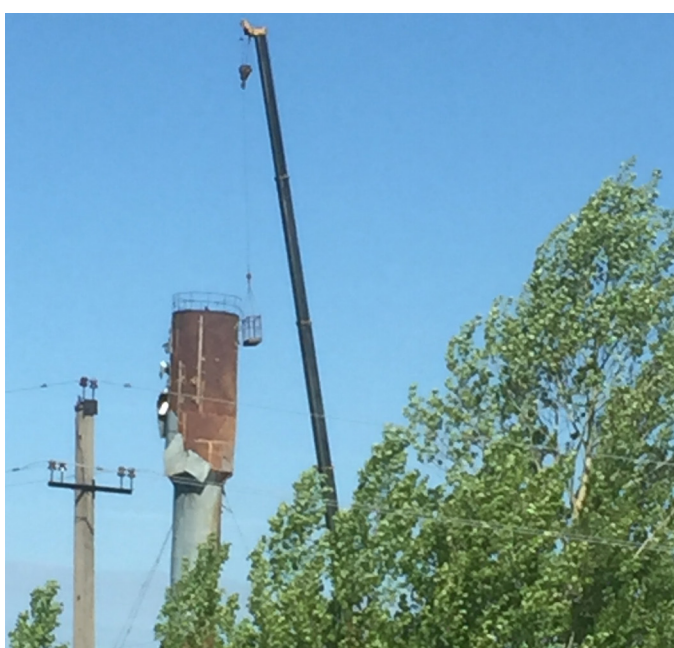
Идет ремонт водонапорной башни
